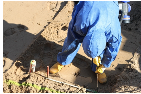
▲ Absteckung der Bohransatzpunkte
